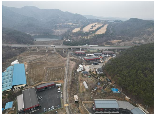
교량 측면 전경
