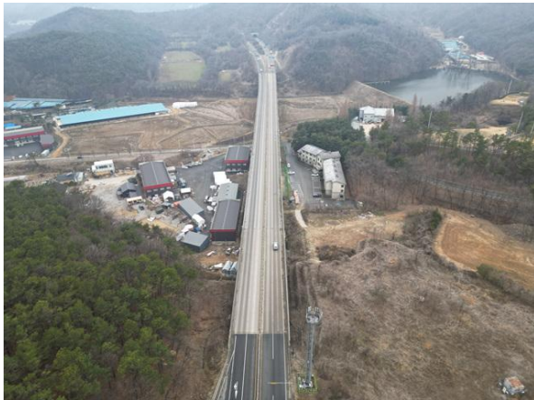
교량 상부 전경
